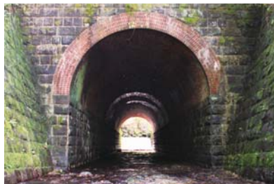
瀬久谷川暗渠
