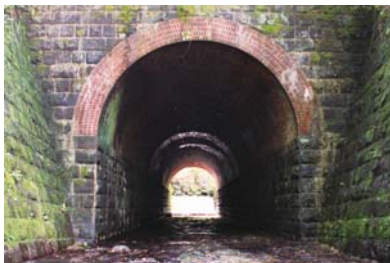
瀬久谷川暗渠
