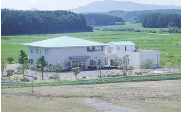
曾於市下水道浄化センター
