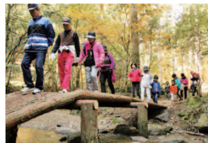
新しく架けられた橋
