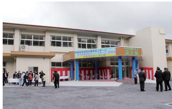
介護施設として生まれ変わった旧南之郷中学校舎
