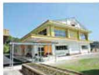
穂小体育館（改築）
