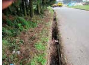
側溝の土砂堆積
