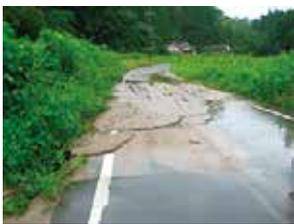
路面の土砂堆積
