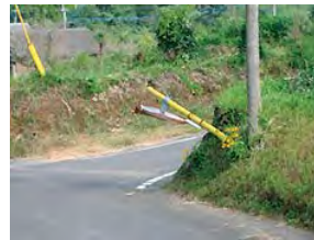
カーブミラーの破損
