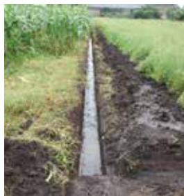
【記録写真例：作業後】
