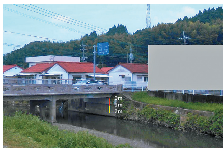
財部地区 財部 新地橋 (後川)
