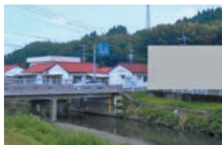
財部地区 財部 新地橋 (後川)
