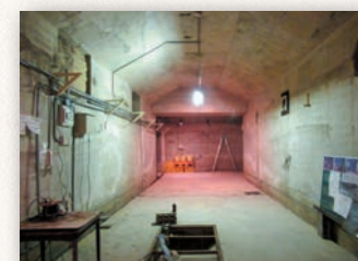
地下発電所跡
