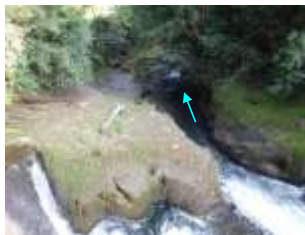
堰下流側の様子
