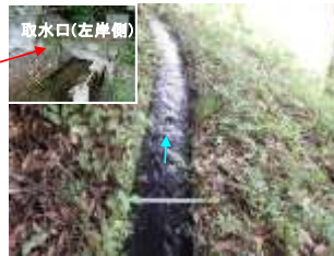
農業用水路(左岸側)
