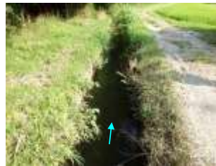
農業用水路(左岸側)
