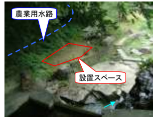
発電設備設置スペース(滝下流左岸)
