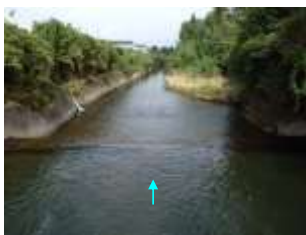
堰下流側の様子
