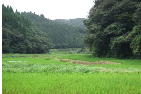
基盤整備(立馬地区)完成
