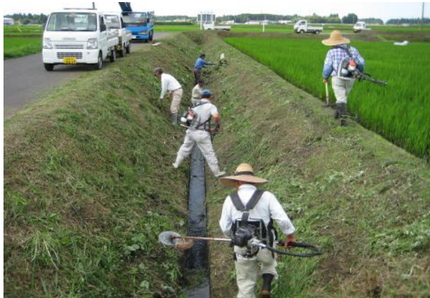
(排水路の草刈り)
