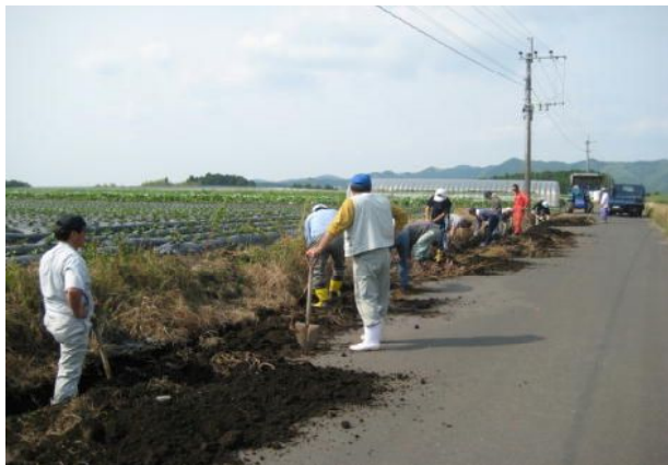
(農道側溝の泥上げ)
