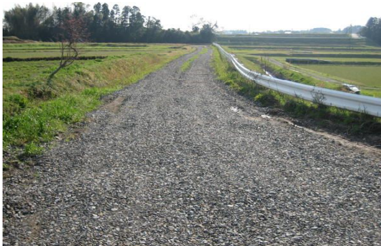
砕石散布状況
