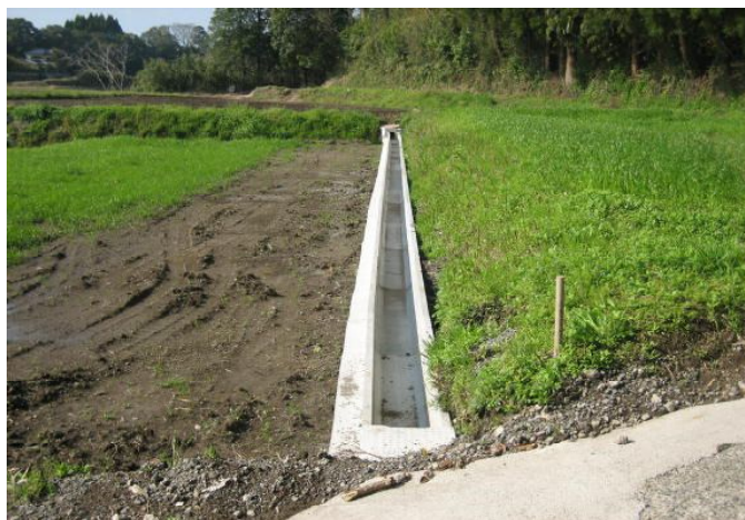
(用排水路整備)
