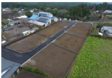
大隅町 大隅北分譲地
