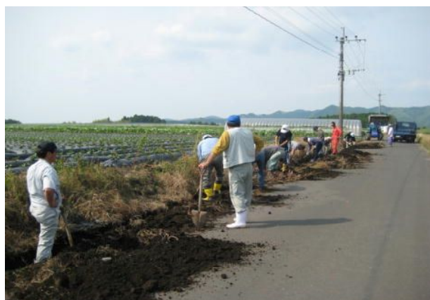
（側溝の泥上げ）
