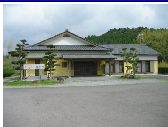
大隅農村環境改善センター
