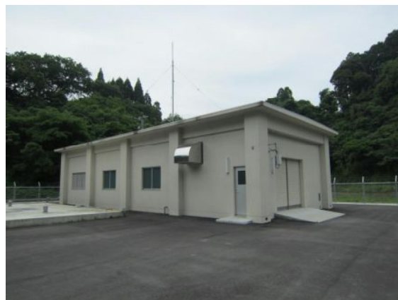
外園揚水機場
