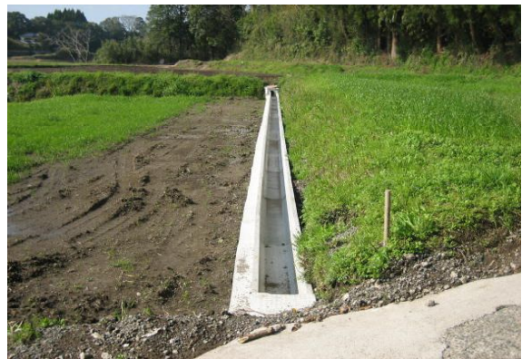
(用排水路整備)
