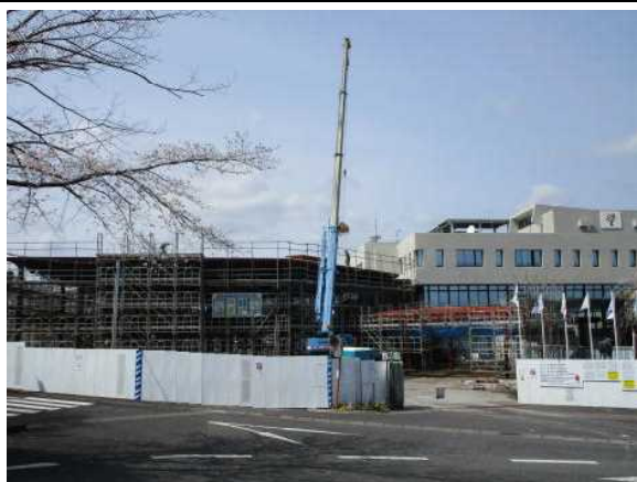
増築庁舎（建設中）
