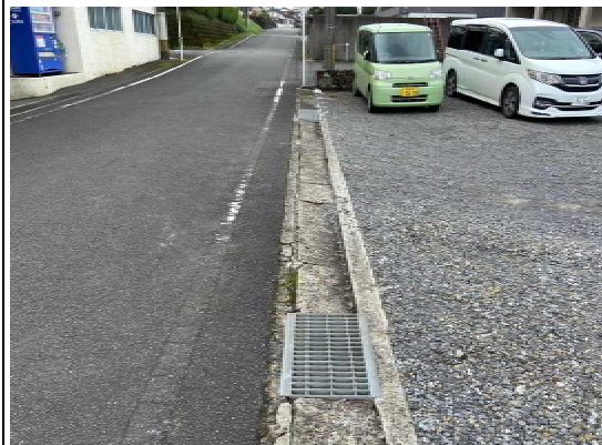
側溝改修予定箇所
