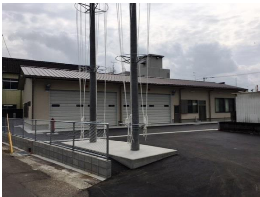
消防防災施設整備事業 財部中央分団詰所
