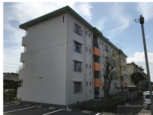
ストック総合改善事業 川内団地 1 号棟
