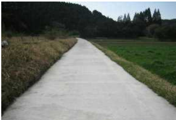
コンクリート舗装
