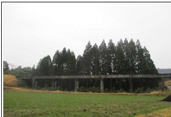
蓑原水路（現況）
