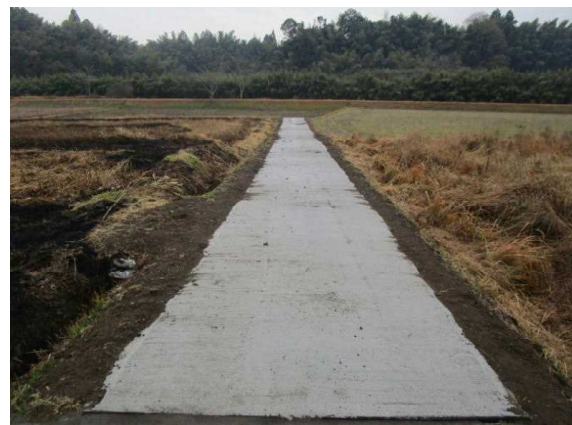
長寿命化（農道のコンクリート舗装）
