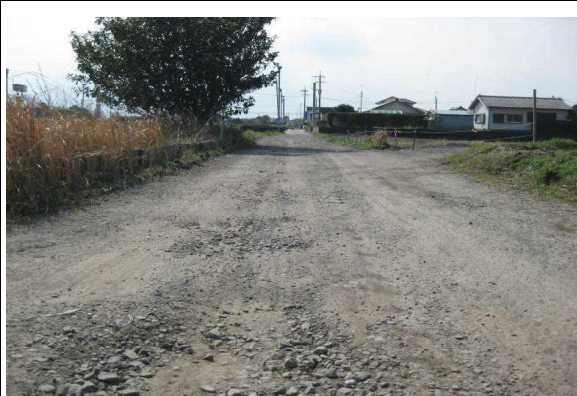
大隅（八合原8号線排水路工事）
