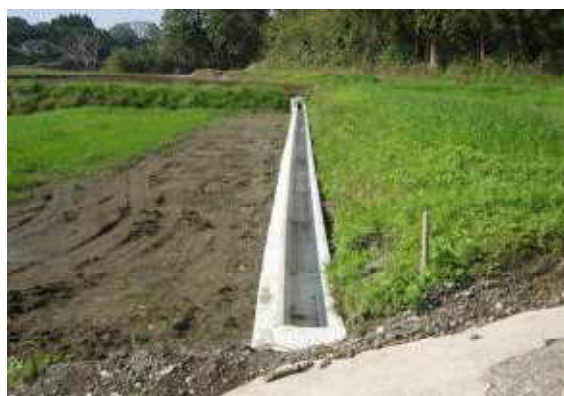
(用排水路整備)
