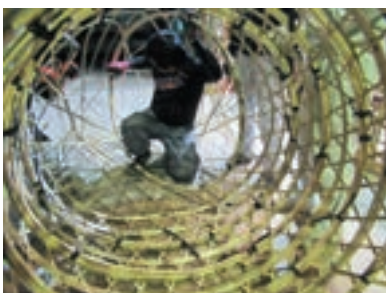
写真 15 中胴 (孟宗竹) を 13 巻 目に入れ込むところ
