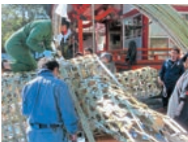
写真 45 両腕の番線での固定完了
