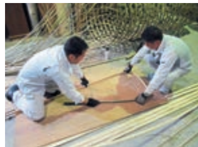
写真 19 手板にあてて確認
