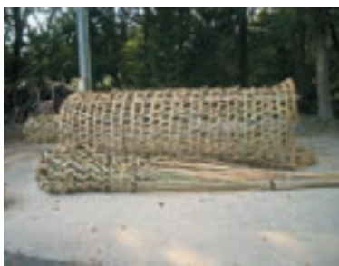
完成した本体
