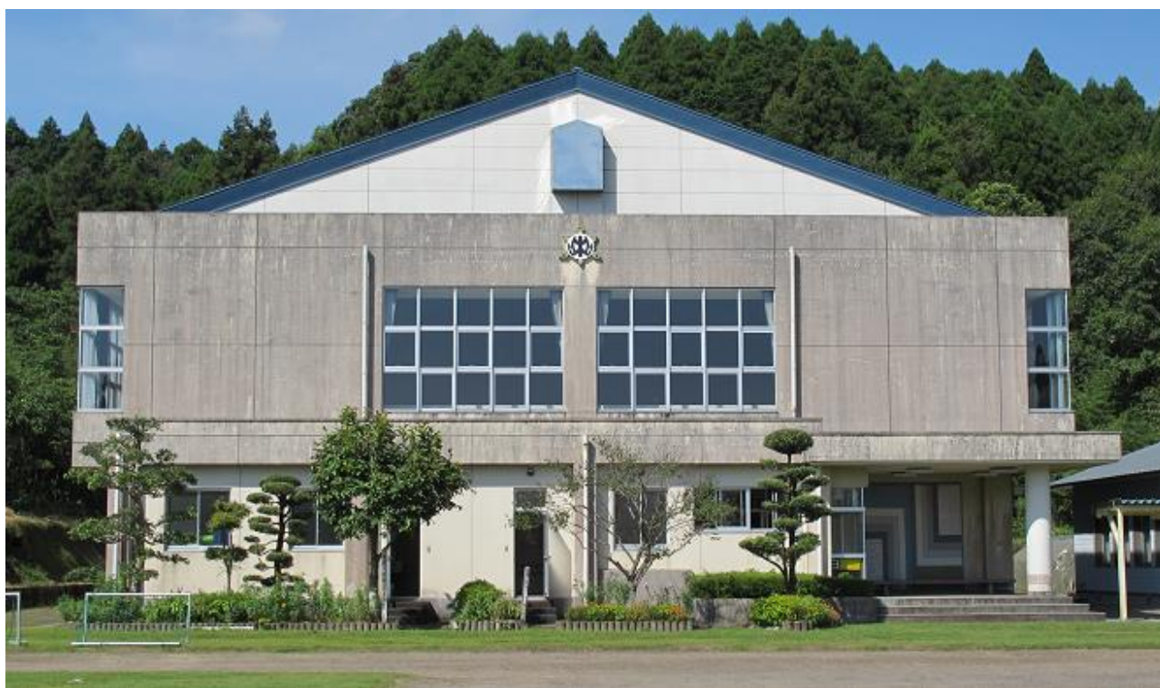
財部北中学校屋内運動場全景
