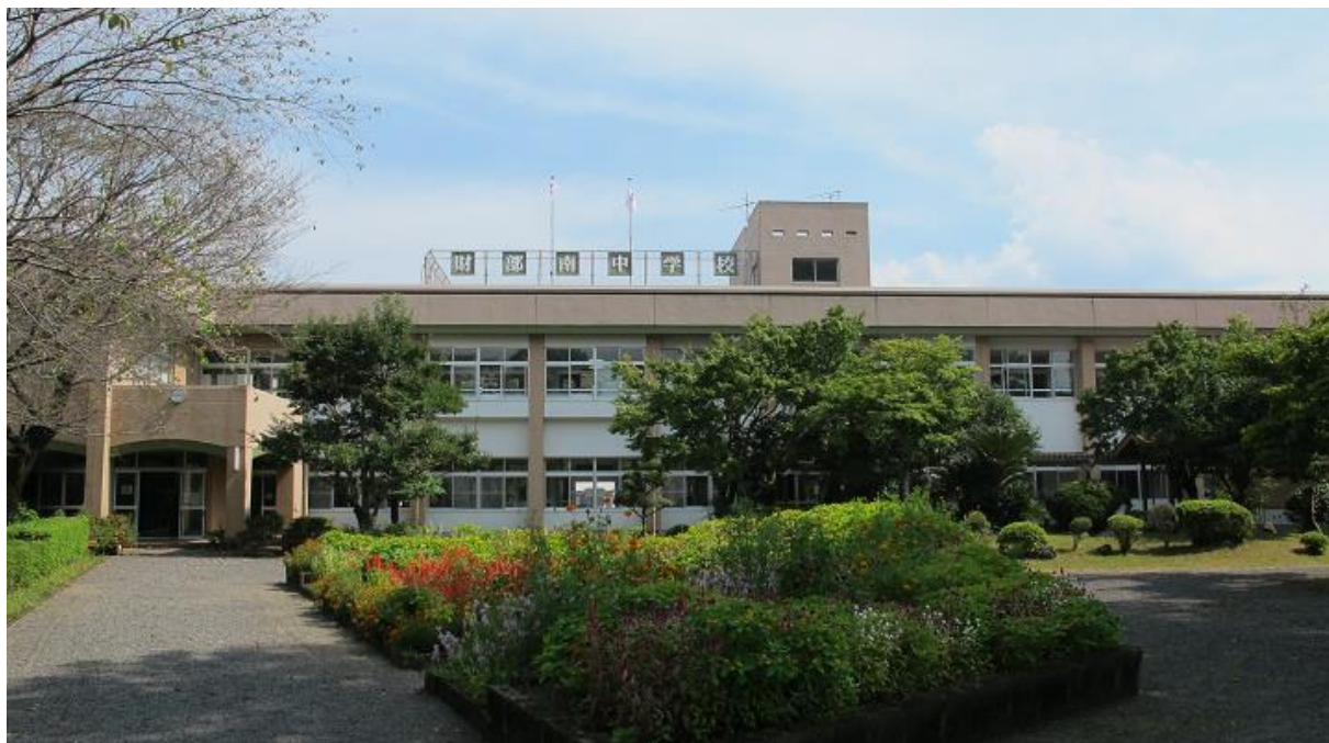
財部南中学校管理教室棟
