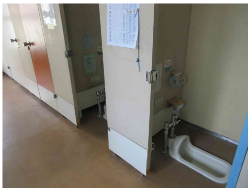
和式トイレ（教室棟1号棟1階）
