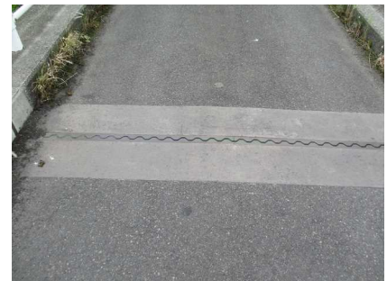
補修後(伸縮装置取替え)
