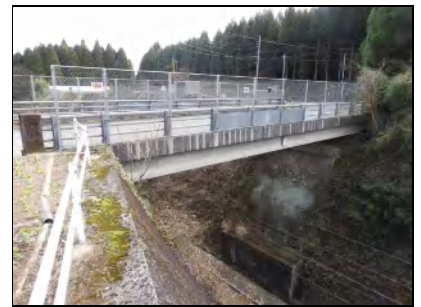
吉ヶ谷跨線橋
