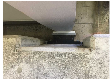
補修後(支承取替え)
