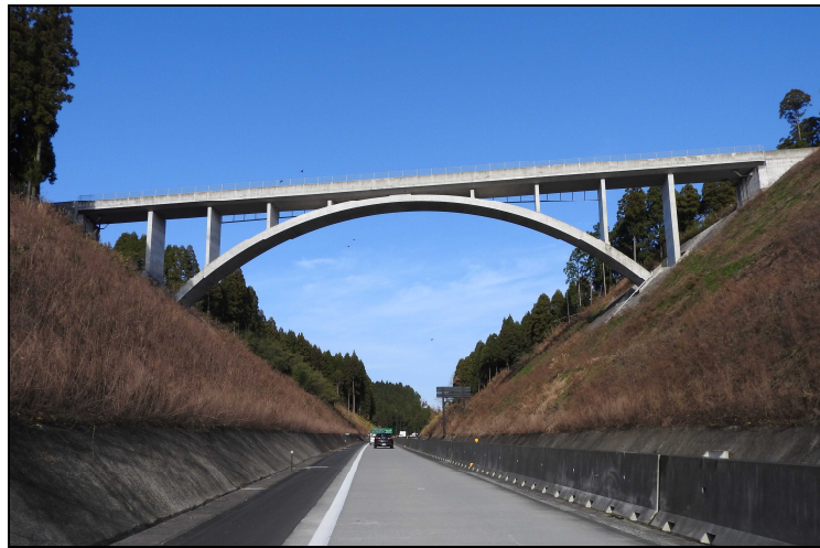
木場田跨道橋
