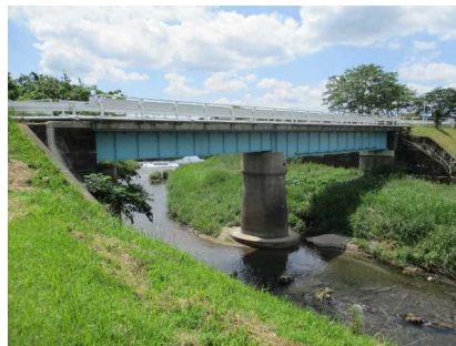
補修後(塗装塗替え)
