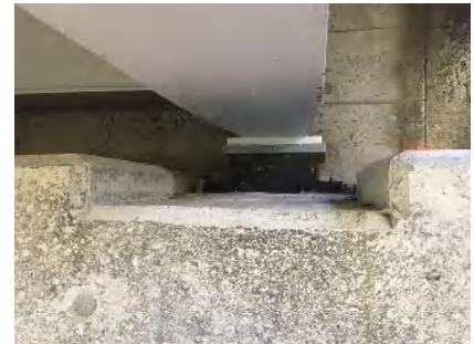
補修後(支承取替え)
