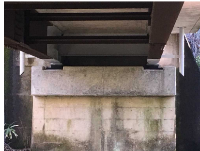
補修後(支承取替え)
