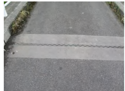
補修後(伸縮装置取替え)
