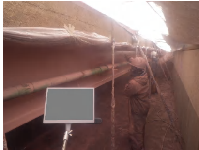
補修状況(塗装塗替え)
