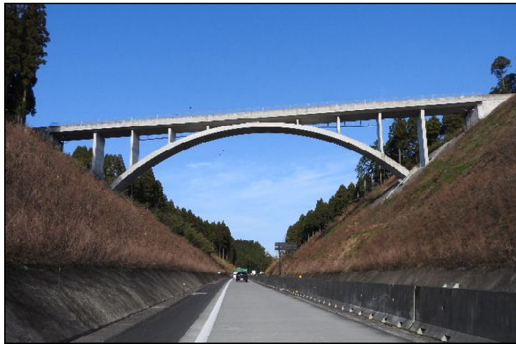
木場田跨道橋
