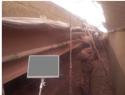
補修状況(塗装塗替え)
