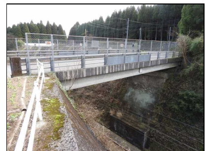
吉ヶ谷跨線橋
