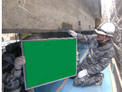
補修状況(断面修復)
