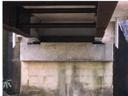
補修後(支承取替え)
