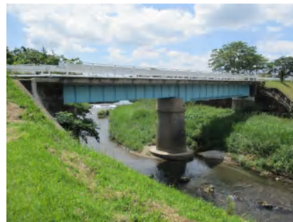
補修後(塗装塗替え)
