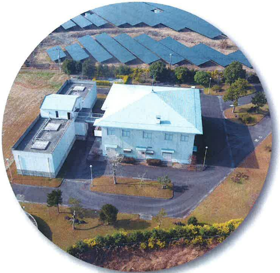
曾於市下水道浄化センター
