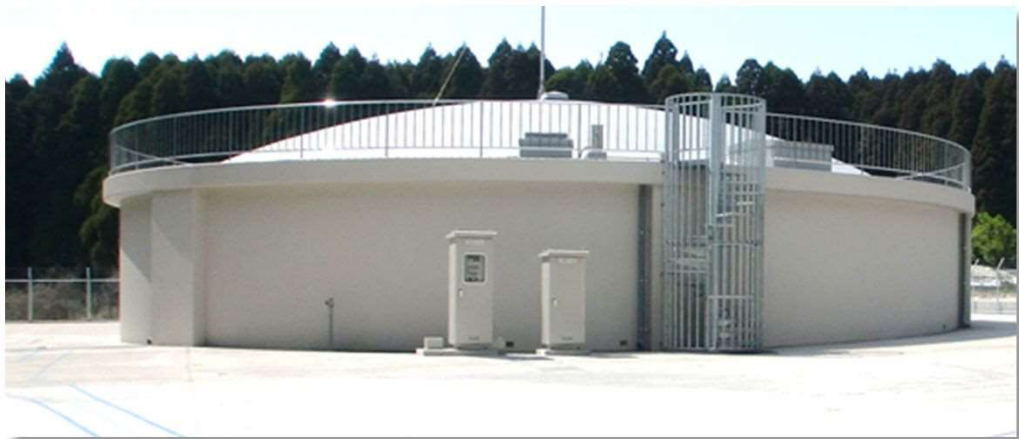
統合により新設された配水池
