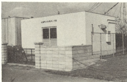
町水道八合原ポンプ室
