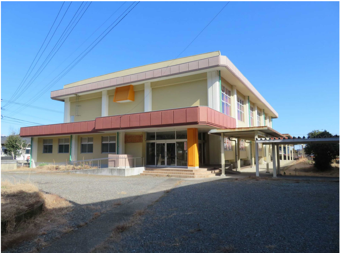
屋内運動場（体育館）
